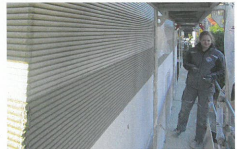
Bild 9: Die Kammzugtechnik eignet sich auch für den Einsatz bei wärmedämmten Fassaden, hier Putz mit durchgehend horizontalem Kammzug. Die Firma Form & Farbe Ehmann hat damit die schlichte Gebäudeform des 8-Parteieinhauses in Erlangen eindrucksvoll aufgewertet
