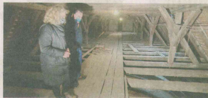
Architektin Stephanie Sauer und Pfarrer Michael Murner begutachteten vor Baubeginn die Dachkonstruktion, welche in der Gewölbeschale des Kirchenraumes darunter Risse verursachte.
