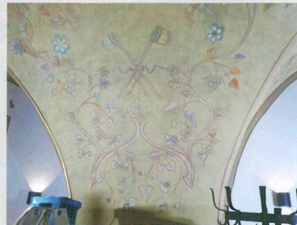
Die rekonstruierte Malerei wurde mit Silikatfarben ausgeführt
