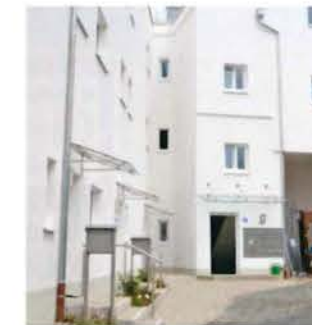
Ein Jahr hat es gedauert – dann war der Bau der Wohnanlage abgeschlossen.
