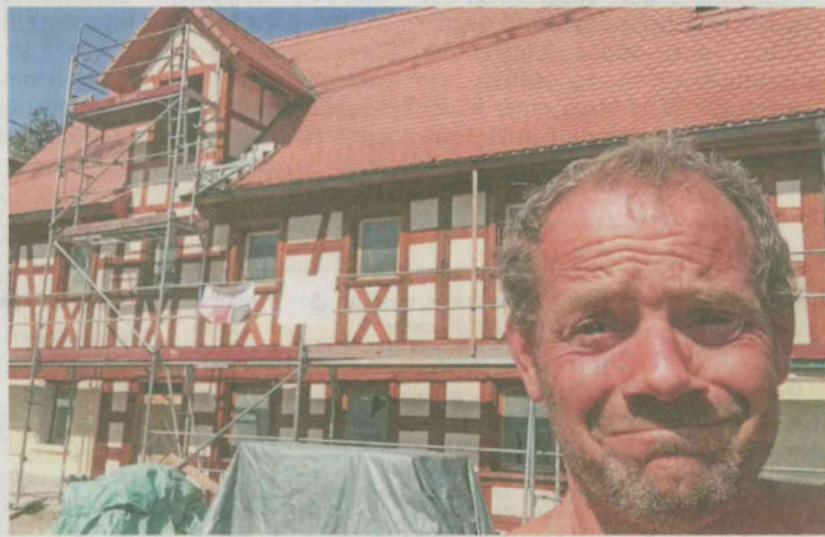
Hermann Stengel ist während der Sanierung manchmal an seine Grenzen geraten angesichts der Arbeit.
