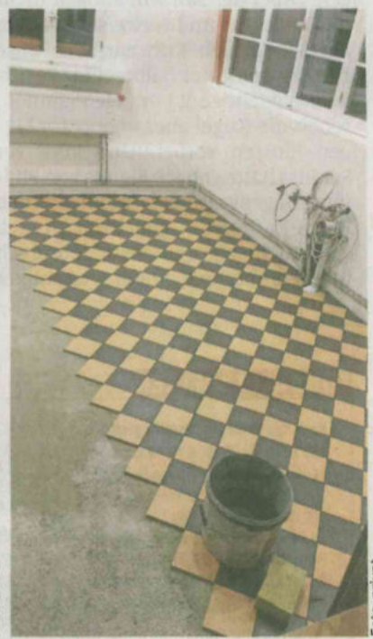
Die Fliesen in den Bädern sind von Uwe Igel verlegt worden.
