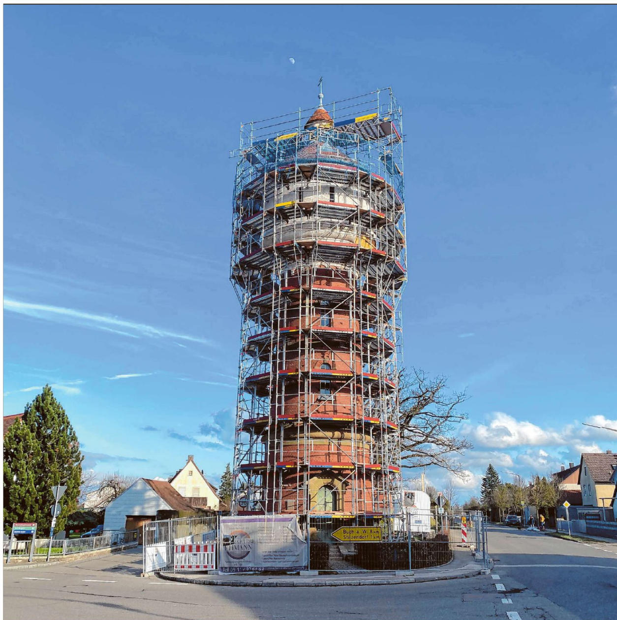
Lange Zeit mussten sich die Schillingsfürster mit diesem Bild anfreunden: der eingerüstete Wasserturm. Im Mai könnten die Arbeiten nun abgeschlossen sein. Archivfoto: Volker Raab
