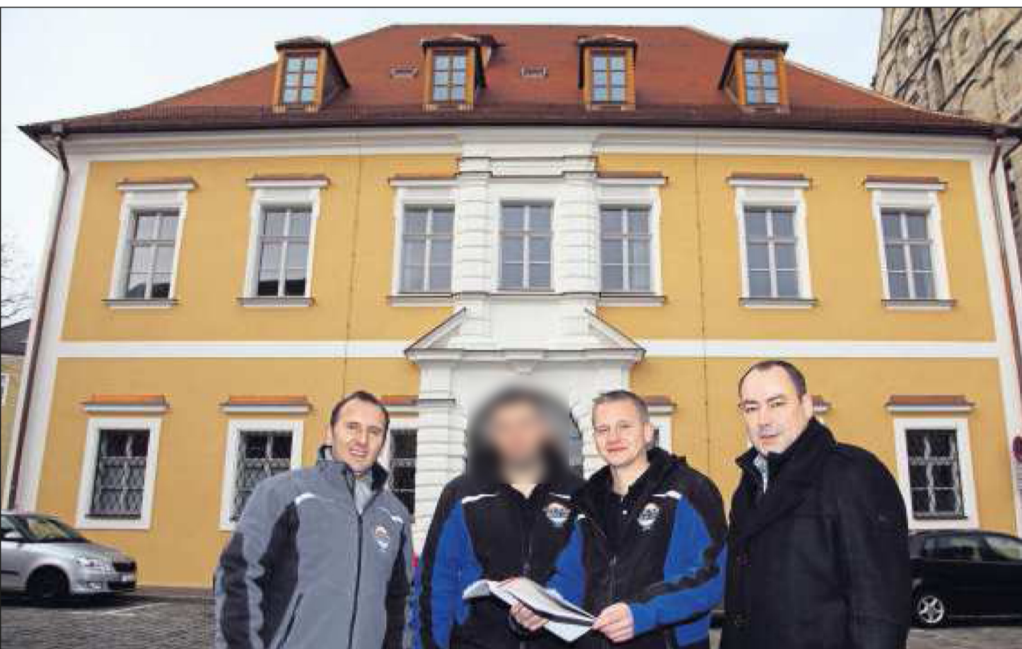
Nach drei Jahren Arbeitszeit sind sie stolz auf ihre ehemalige Baustelle. Die Fassade des Landgerichts (im Hintergrund) wurde in den Original-Zustand versetzt. Von links: Vorarbeiter Beqiraj Gazmend, Projektleiter [Name] , Form- & Farbe-Geschäftsführer Matthias Ehmann und Malermeister Rainer Ruffertshöfer von Keimfarben.
